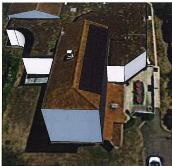
Figure IX-6 : Vue de l'implantation des modules photovoltaïques sur la toiture étudiée
