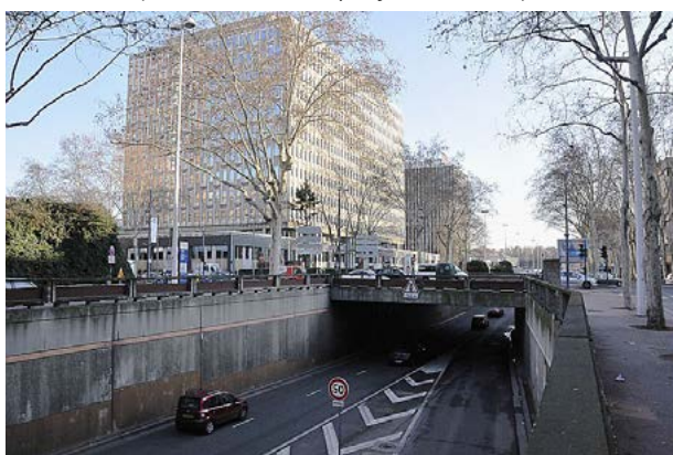
Rue Garibaldi (avant travaux de requalification – 2012)
