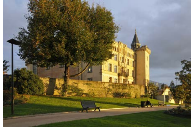
Usine des eaux, Caluire-et-Cuire
