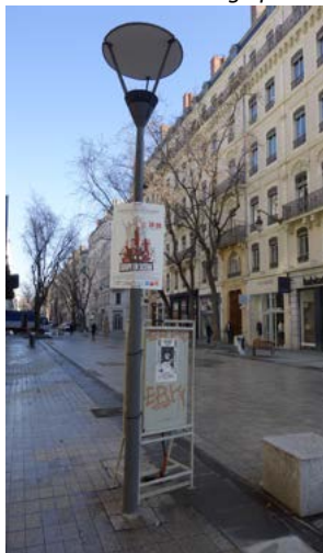
Exemple de dispositif illégal apposé sur une installation d'éclairage public
