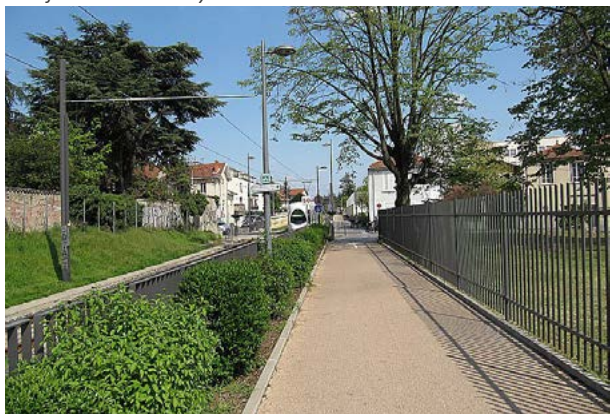
Voie ferrée du tramway T3
